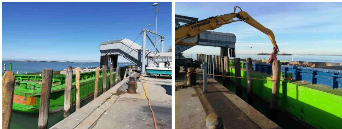
Figura 4-20: Area dedicata al trasbordo su chiatte dei rifiuti raccolti nella zona Estuario
